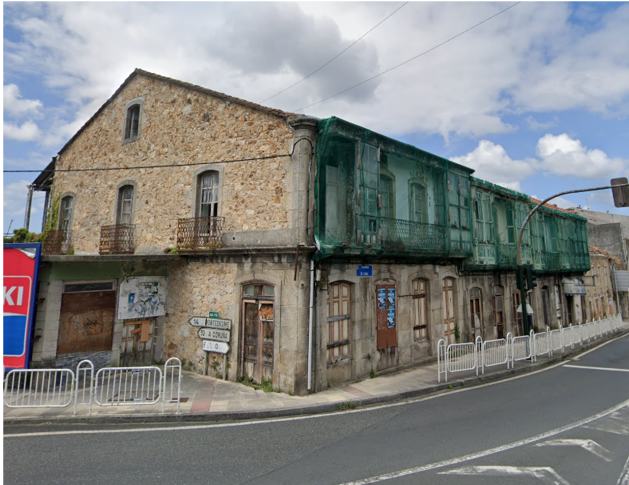
Foto 1. Estado actual Couzada de casas no Portádego.
